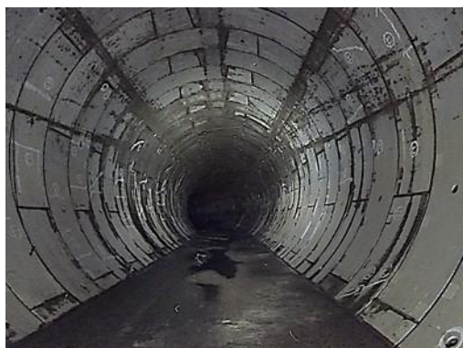
写真 1-9 神田川環状 7 号線地下調整池
