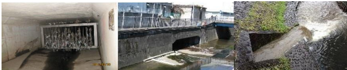
左 写真 1-2 善福寺川最上流部美濃山橋下水道排水口。 中 写真 1-3 上流域原寺分橋より下手にある下水道排水口と湧水ポイント。 右 写真 1-4 中流域・都立善福寺川緑地内の排水口。
