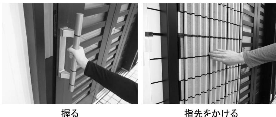
写真5-1 把手への手のかけ方の事例
