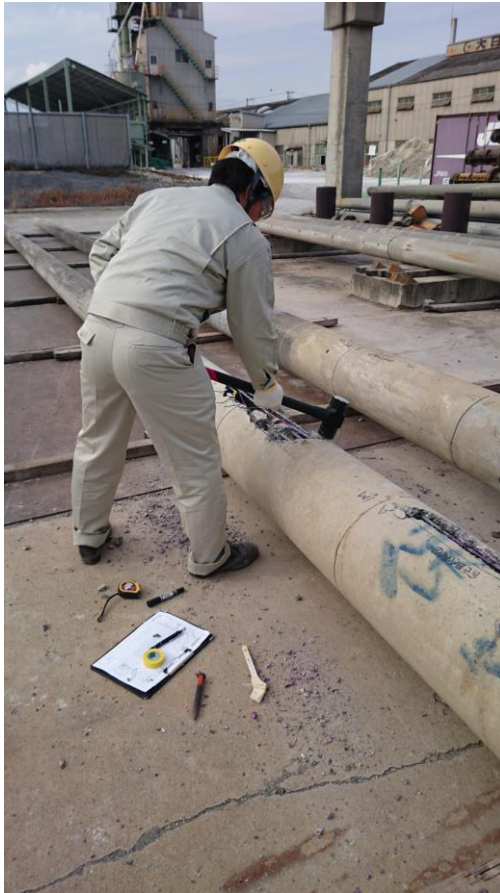
図 2-3. 実暴露 CP の解体の様子
