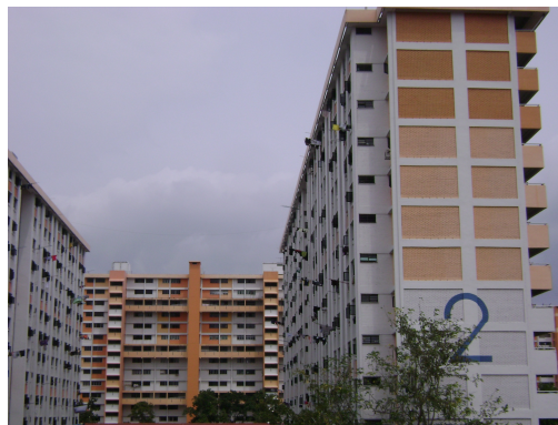
Picture 6-2. 集合住宅 HDB の大きな屋根 ( https://encounteringurbanization.wordpress.com )
