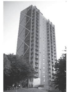
図1 J2棟の外観
