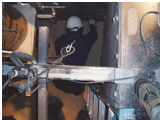
(c) 珪砂撒出し状況
