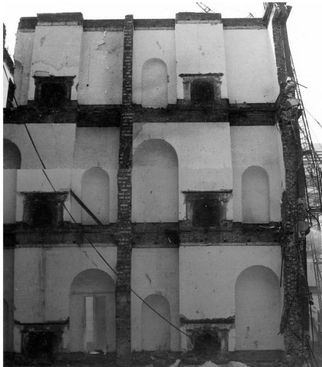
図 5-17 事例Ⅳ：旧三菱一号館 当初 壁のアーチ部（解体時写真） （三菱地所所蔵）
