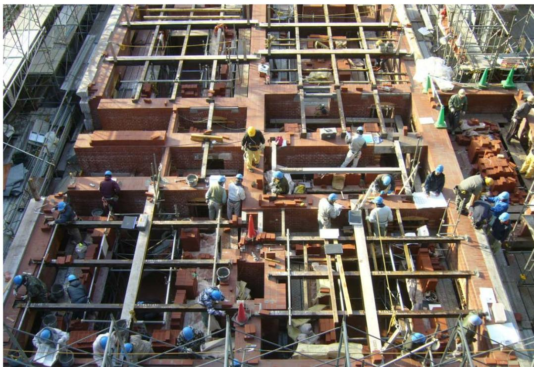
图 5-12 事例Ⅳ：三菱一号館 再現 煉瓦積み工事
