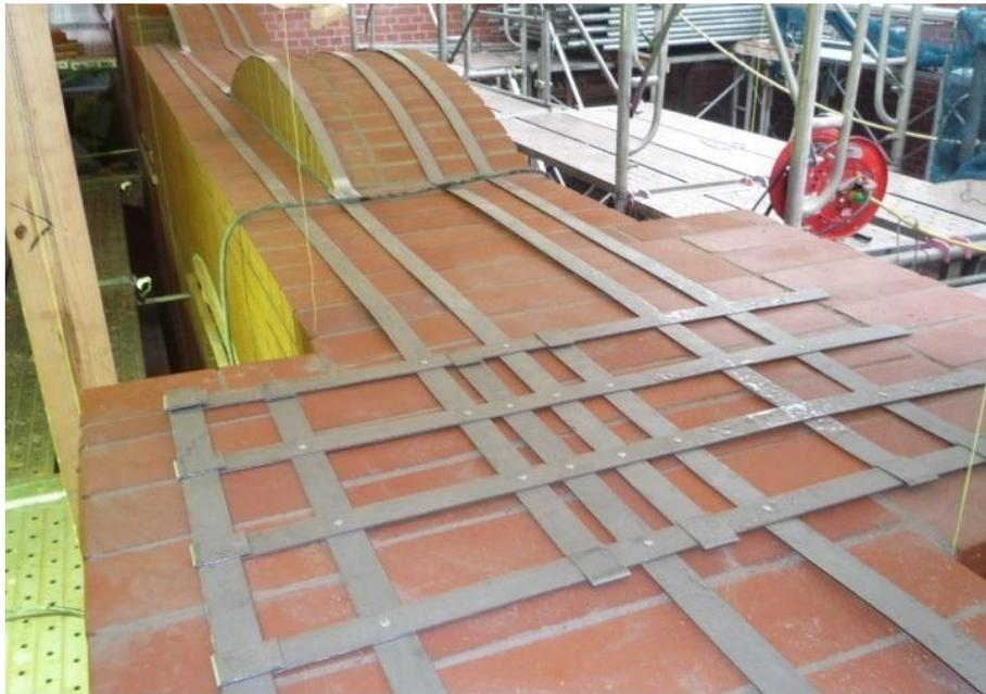
図 5-13 事例Ⅳ：三菱一号館 再現 帯鉄の敷き込み
