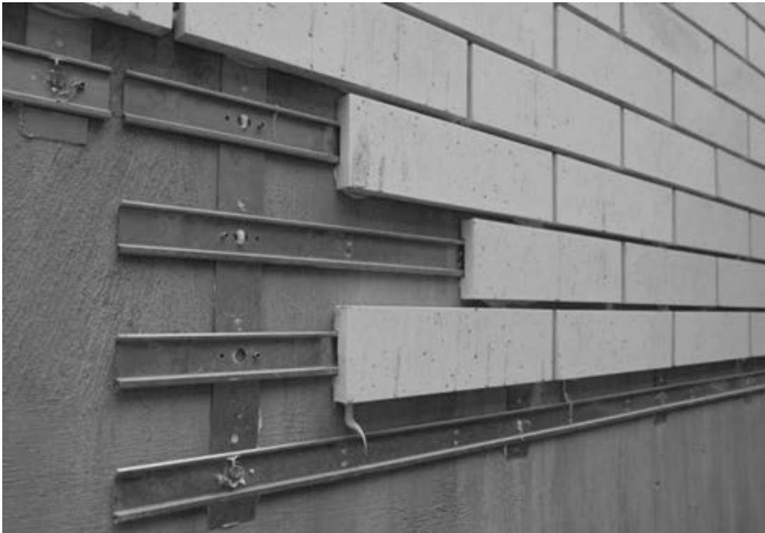
図 3-16 新建物 再現タイル・乾式レール工法
