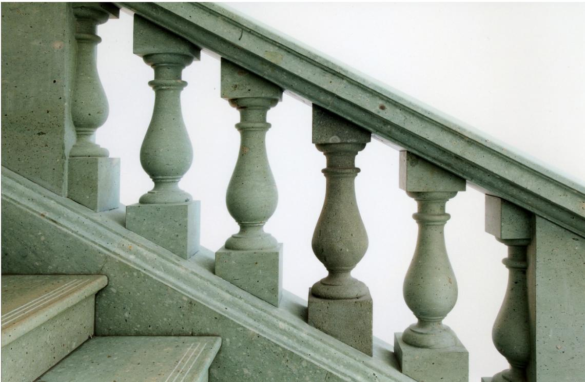
図 5-20 事例Ⅳ：三菱一号館 再現 保存材（原位置復旧）と再現材の並置
