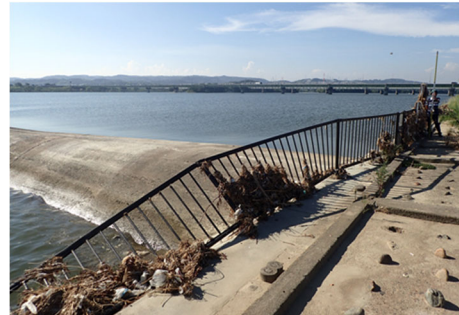
図-8 高梁川河口潮止堰の豪雨後の状況(右上方向が上流)
