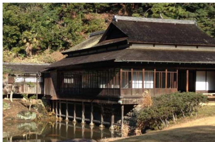
写真 6-4 臨春閣第二屋外観
