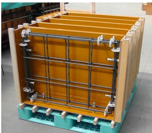
型枠・配筋状況
