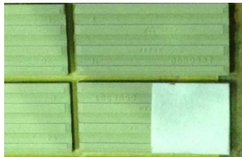
写真 4.1 模擬剥離範囲 T 部における特殊シート
