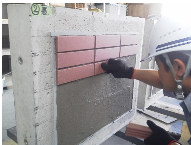
写真 2.6 タイル張付け状況
