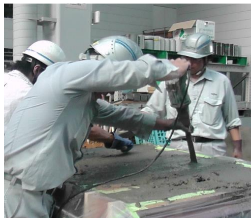
コンクリート打設状況
