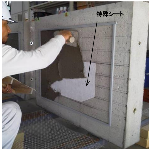
写真 2.3 模擬剥離用特殊シート埋設状況
