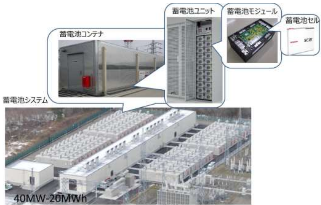
図 1-3 リチウムイオン電池 大容量化:蓄電池セルから蓄電池システムへの拡張の一例
