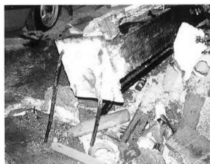
c-2) アンカーボルトの引抜
