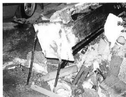
c-2)アンカーボルトの引抜
