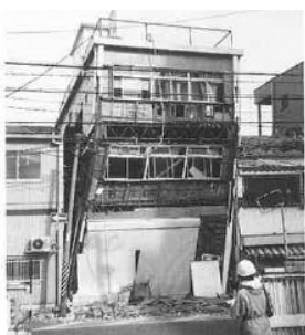
a-1)柱頭降伏による層崩壊
