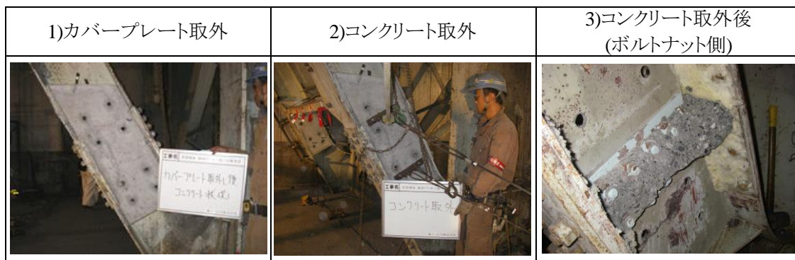
写真 3-5 コンクリート解体手順
