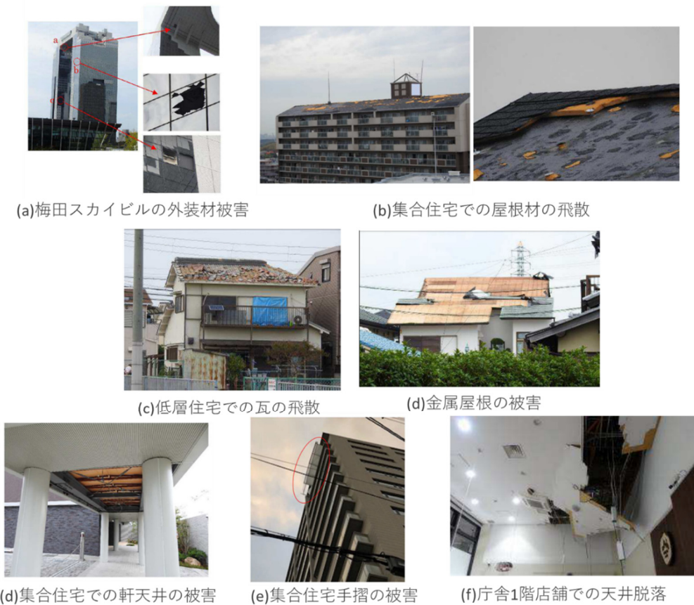
図 4-14 建物被害の例 [10]
