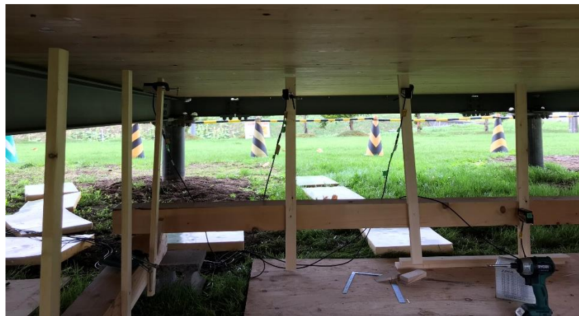
写真 4.2 レーザー変位計設置の様子
