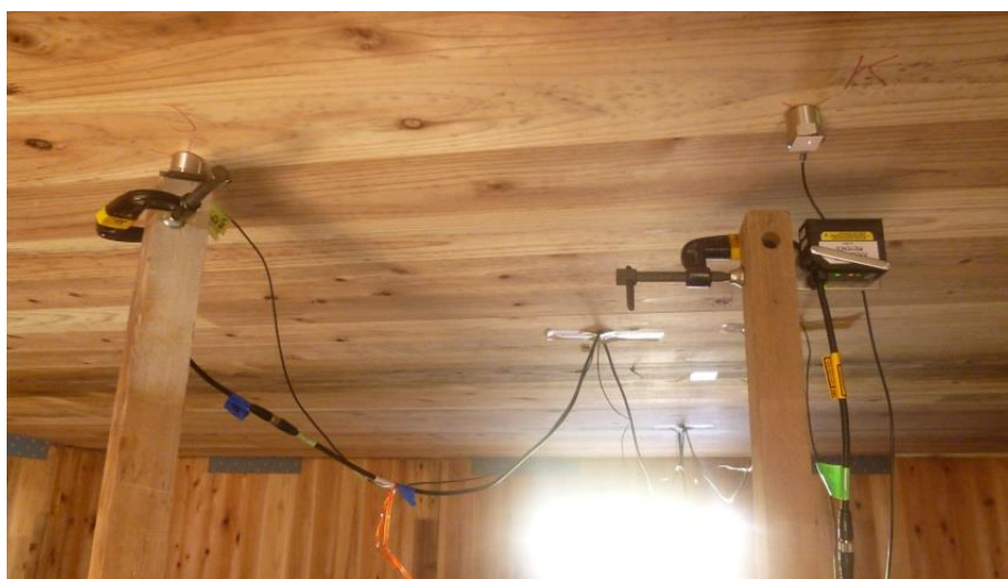
写真 3.11 測定機器設置の様子
