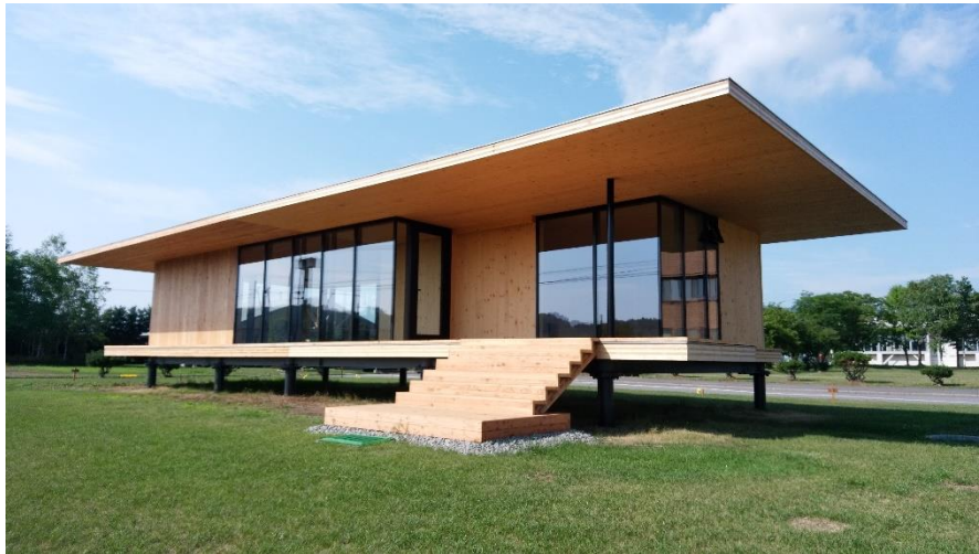
写真 4.1 対象とした CLT 造建築物の外観
