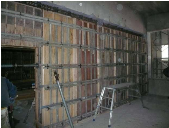
(c)RC 耐震壁工事
