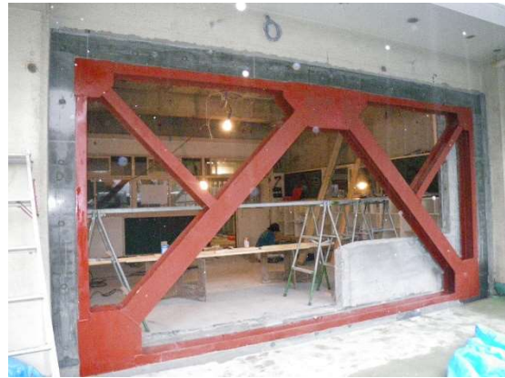
(d)枠付き鉄骨ブレース工事
