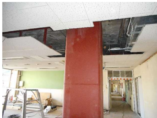
(b)RC柱の鋼管巻き工事
