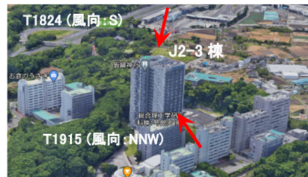
写真1 北側から見たJ2-3棟と周辺の地形と建物 10)
