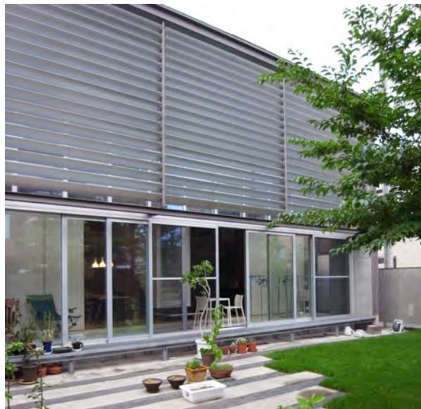
図4-4 日射制御ルーバーの定型の実践例<sup>注2)</sup>
