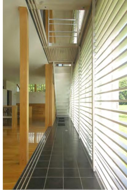
図 1-16 日射制御の手法イメージ
