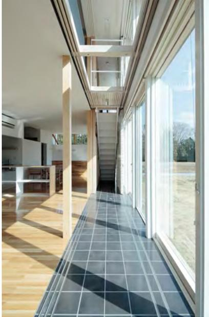
図 1-15 ダイレクトゲインの手法イメージ
