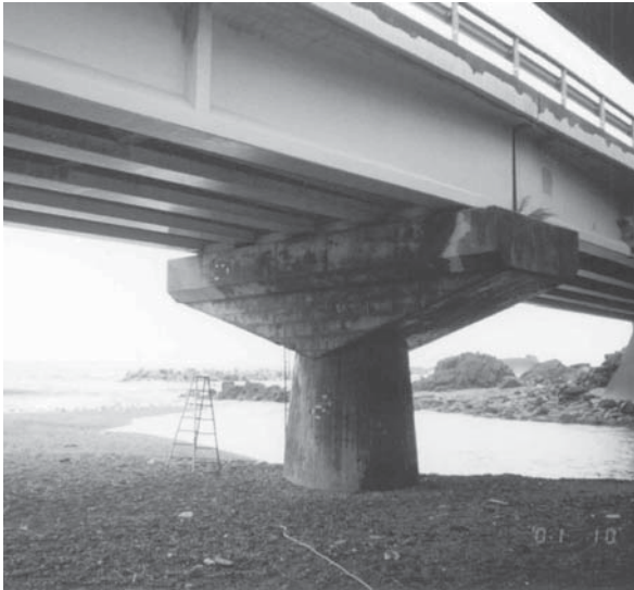
図-3.4 IW 橋 P8 橋脚の外観とその周辺環境
