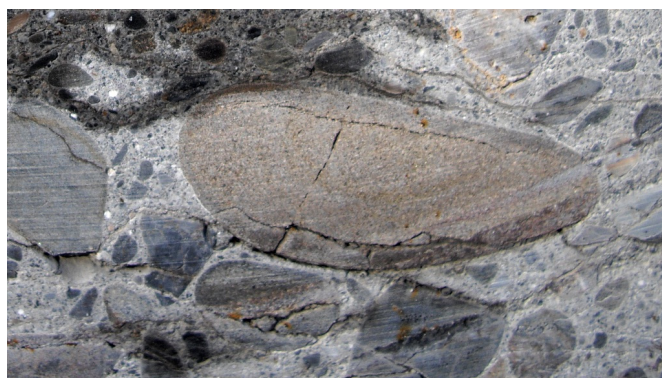
図-6.28 G橋床版の切断面に見られた骨材の表層破壊
