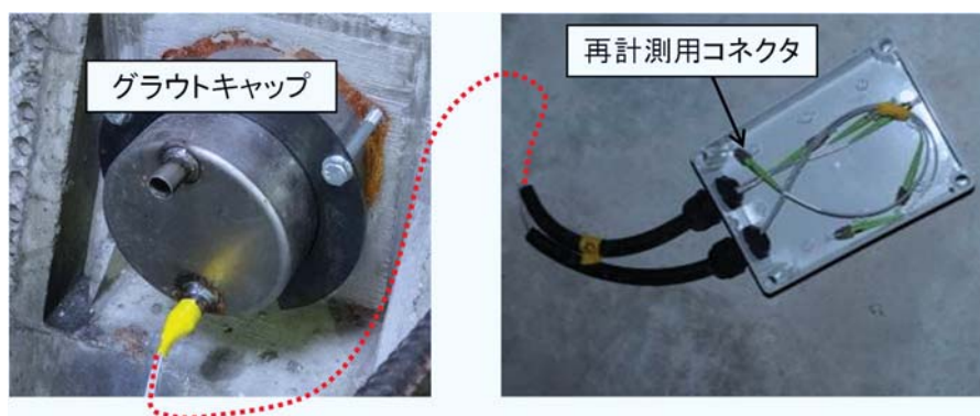
b) グラウトキャップからの取出しおよび再計測用コネクタの残置
