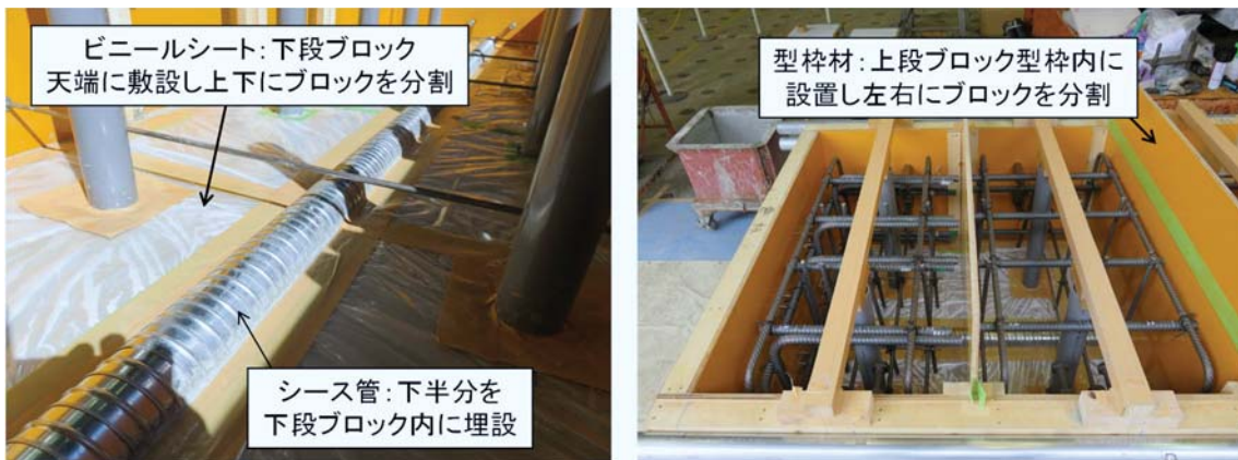
c) コンクリートブロックの製作状況 (下段ブロック打設後)
