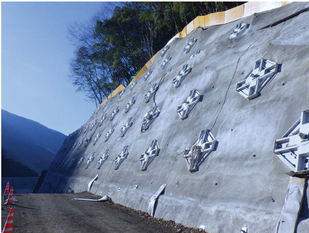
b) グラウンドアンカー工施工後の法面写真
