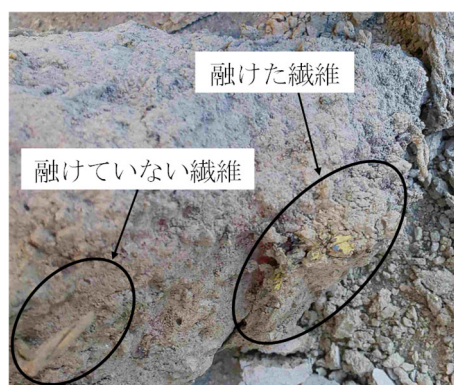
図-11 高温下荷重後の黄銅繊維補強コンクリート内部
