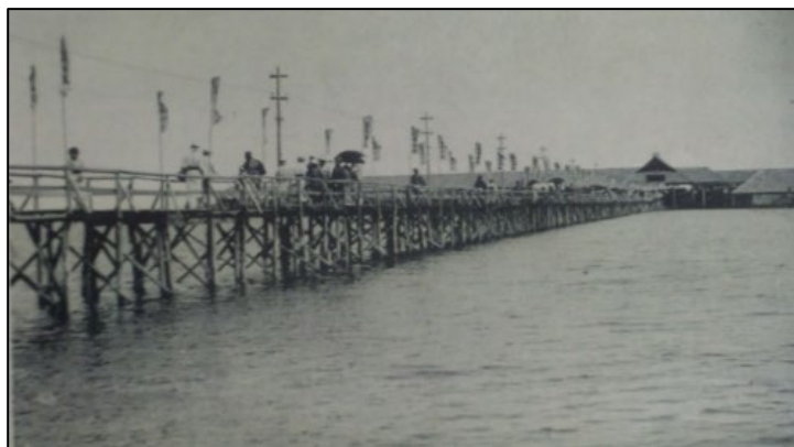
写真-7-3 新子安海水浴場入口にあたる大栈橋 10)
