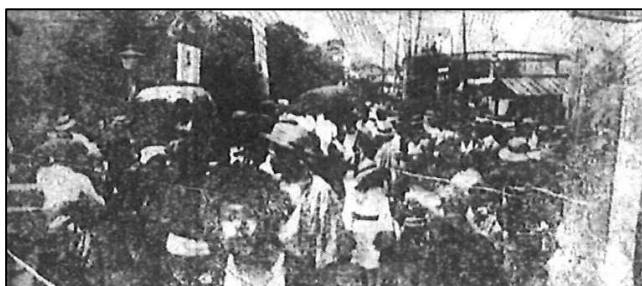
図-5-4 花火大競技会当日に 混雑する大森停車場前の様子 19)
