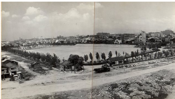
図 4-1-8 鞆公園の建設風景
