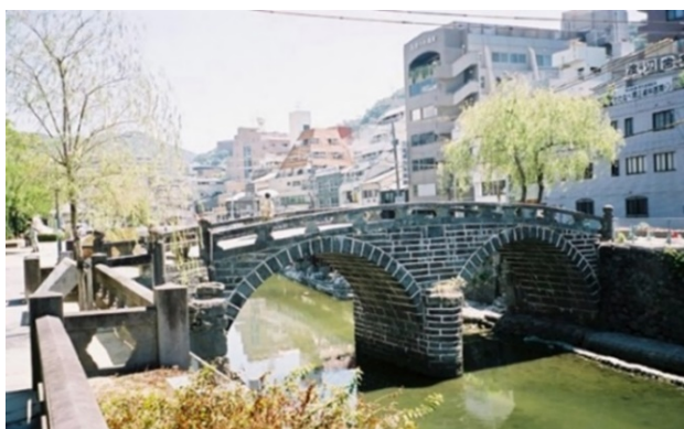
図 5-1-6 改修後の眼鏡橋
