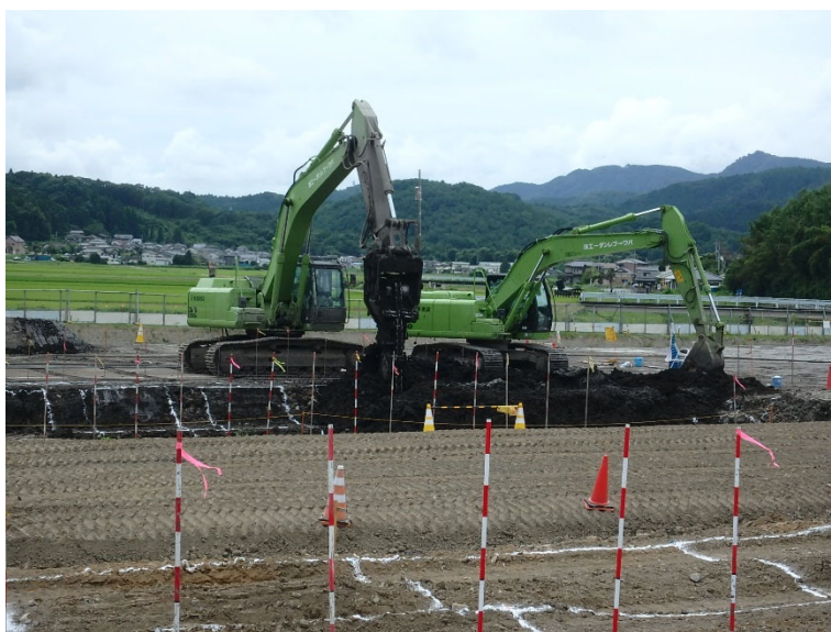
図 1.2.1.8 中層混合処理工法の施工状況例
