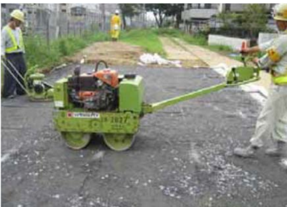
写真 3.3.2.2 試験路盤の造成
