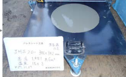
⑥ モルタル注入
