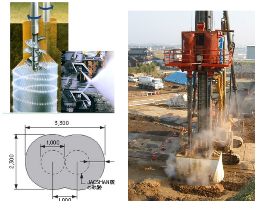
図 1.2.1.13 機械攪拌・高圧噴射併用工法
