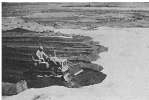
図 1.2.2.4 シート工法の施工状況例（文献 33) から抜粋）
