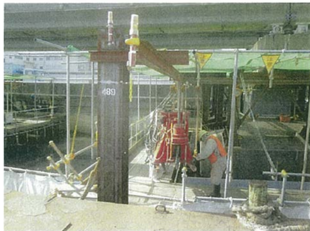
図 1.2.1.11 高圧噴射攪拌工法の施工状況例
