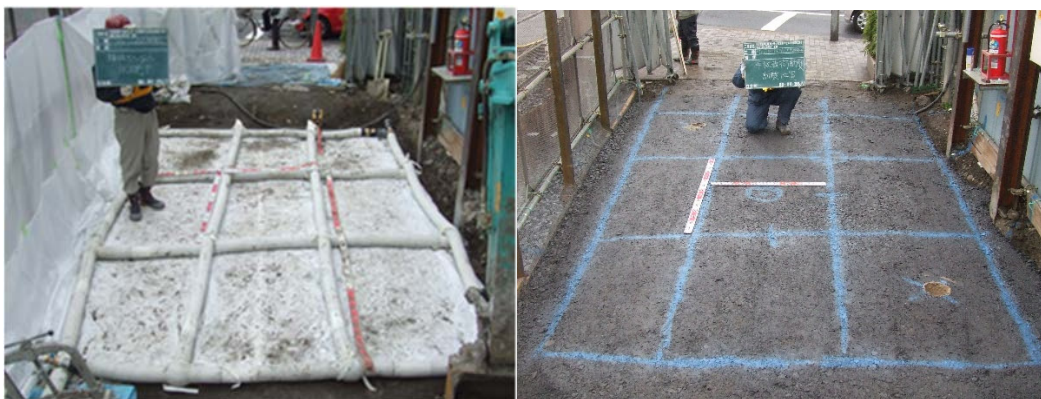
図 3.5.3.2 試験施工の状況 (格子間隔 1\text{m} \times 1.5\text{m} )
