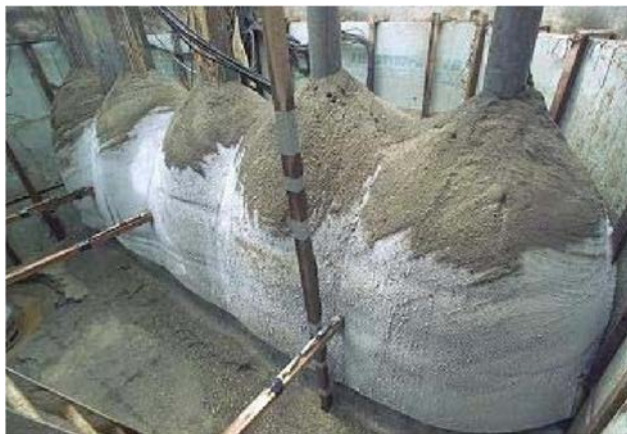
図 1.2.1.15 凍結工法で造成した凍土の様子
