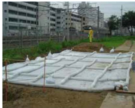
写真 3.3.2.1 格子状補強シートの施工 (左:敷設直後、右:モルタル充填後)
