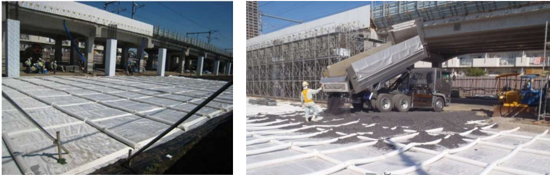
図 4.4.2.10 格子状補強シートと覆土の施工状況
