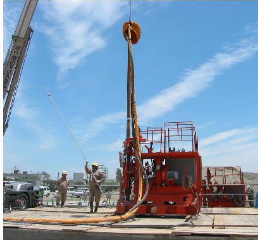
図 1.2.1.10 高圧噴射攪拌工法の施工機械
