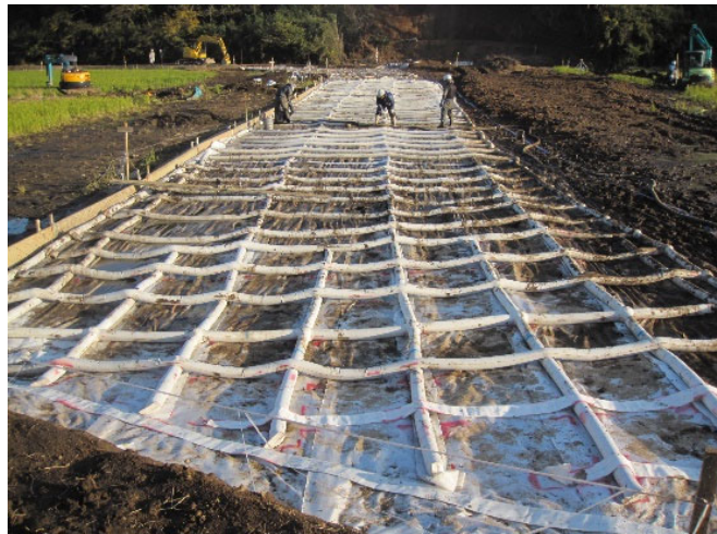
図 3.5.1.4 工事用道路への適用事例 (No.4)
