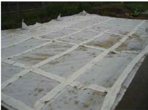
写真 3.3.2.1 格子状補強シートの施工 (左:敷設直後、右:モルタル充填後)
