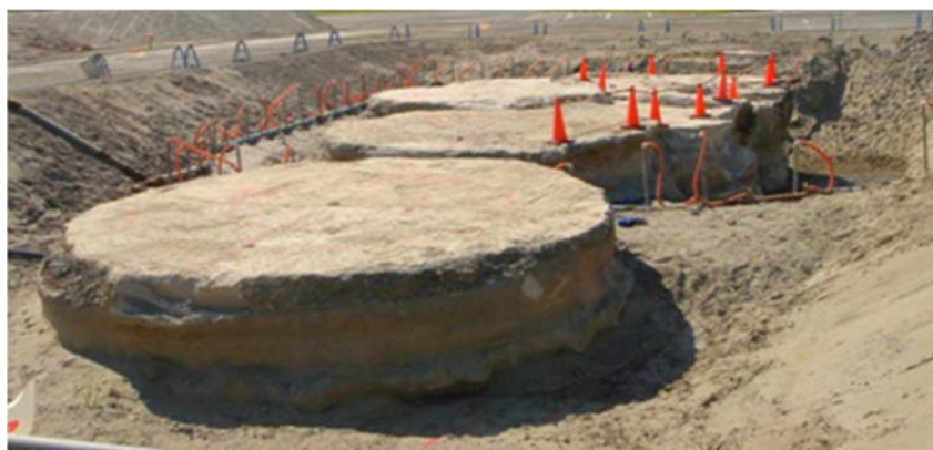
図 1.2.1.12 高圧噴射攪拌工法で造成した改良体（ \phi 5\text{m} 級）の例
