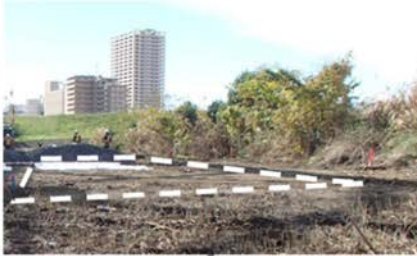
② シート材敷設
