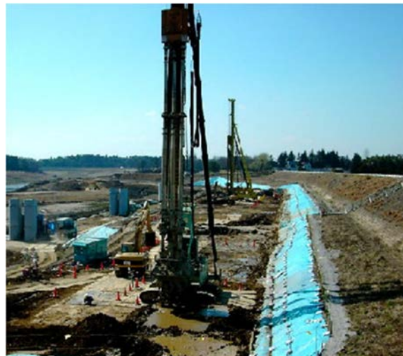
図 1.2.1.5 深層混合処理工法の施工状況例
