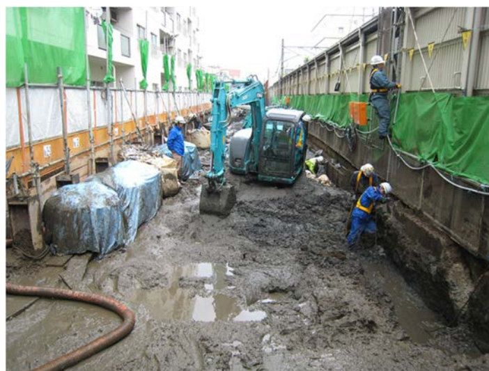
図 3.5.3.1 仮設軌道の床付け掘削状況
