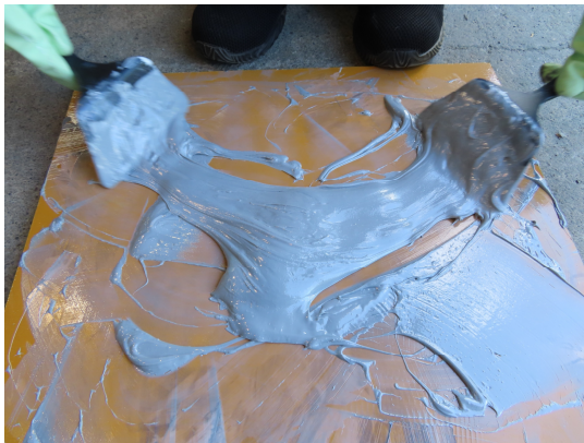
(c) 主材と硬化剤の混合
