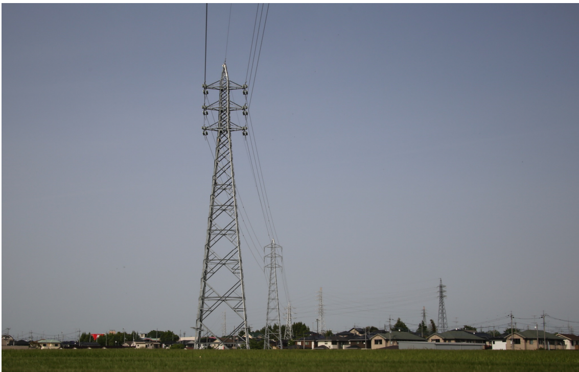
図 1.1.1 送電用山形鋼鉄塔 1.4)
