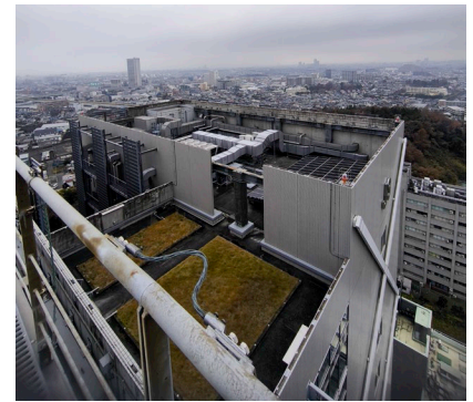
図7 J3 棟増築後の北側風速計位置付近におけるNW方向の景観
