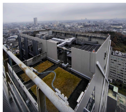
図 7 J3 棟増築後の北側風速計位置付近における NW 方向の景観
