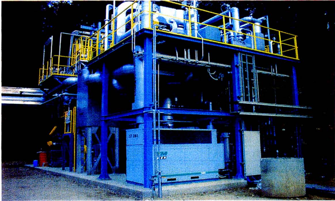
図 3-1 スターリングエンジンを用いたガス化発電システムの全景
