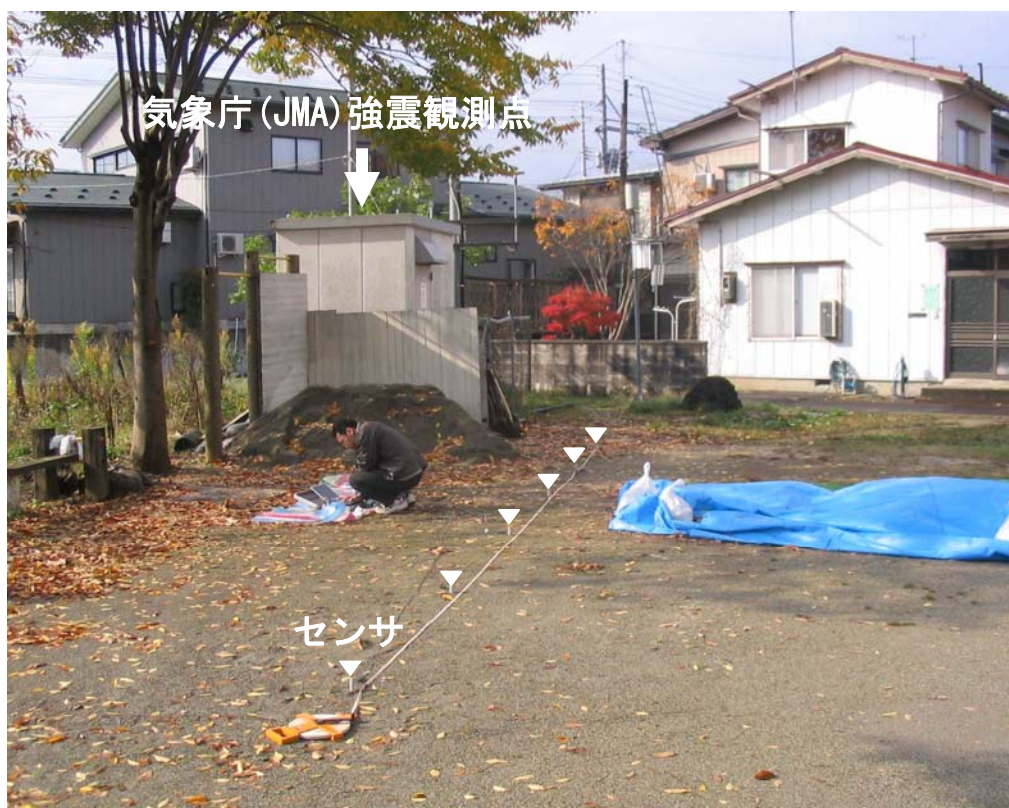
写真 4. 2. 2-2 強震観測点での表面波探査 (JMA)
