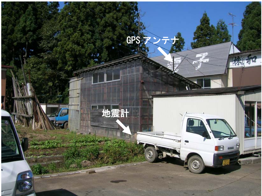
写真 4. 3. 3-3 地震計設置地点 (No. 4 地点、時水)
