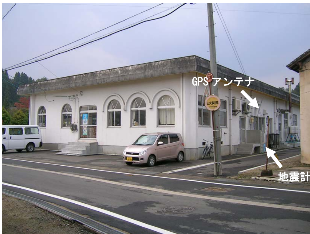
写真 4. 3. 3-2 地震計設置地点 (No. 5 地点、吉谷保育園)
