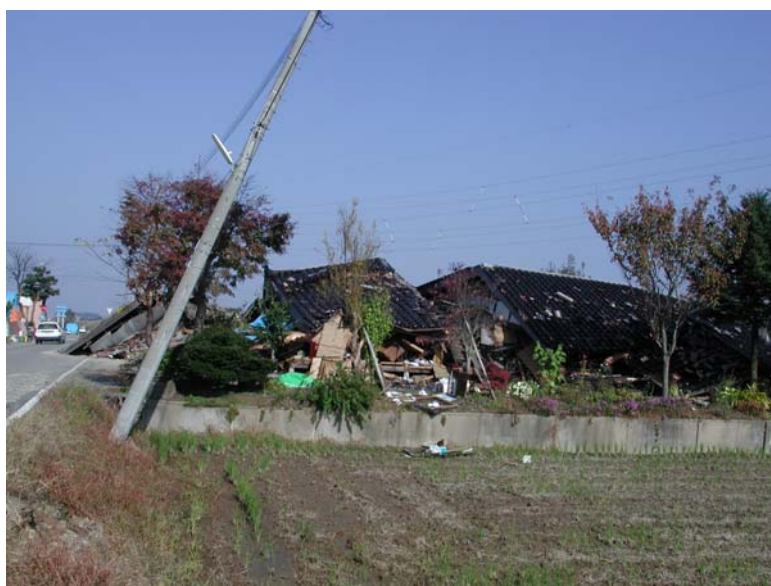
写真 1.1.1 小千谷市吉谷地区での住宅の倒壊（小千谷市役所より提供）
