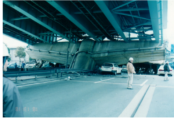
(b) 上部段落しから下部段落しに至るせん断破壊モード
