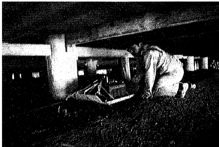
図 5.33: 鶴林寺：レーダ探査風景
