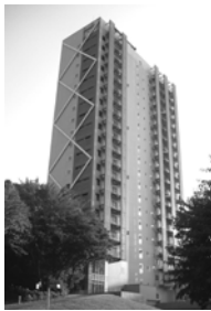
図1 J2棟の外観
