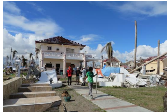
写真-4 Bislig, Tanauan の被災した建物
