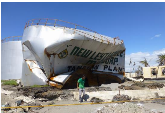
写真-3 Tanauan の製油所におけるオイルタンク被害
