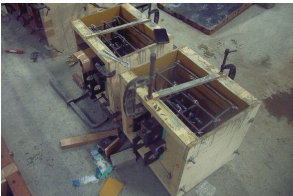
(d) Formwork for precast concrete segment
