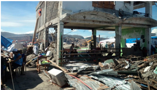
写真-1 タクロバンにおける被災状況
