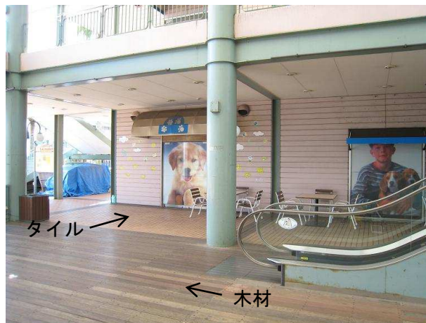
図 2-16 床面の構成材料の様子
