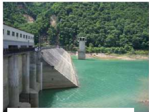
図-2.4.21 石淵ダム(上流側) 33)
