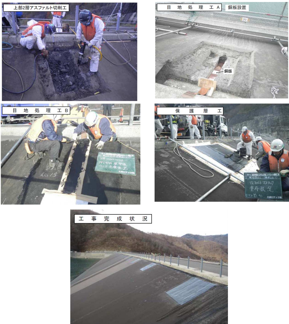
図-6.6.3(2) 天端コンクリート部の補強工状況
