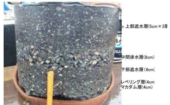
図-3.3.2 左岸側採取コア写真
