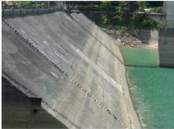
図-2.4.19 表面遮水壁の様子 33)
