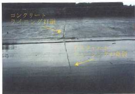
図-2.4.41 コンクリートライニングの打継目により生じた亀裂(1) 42)
