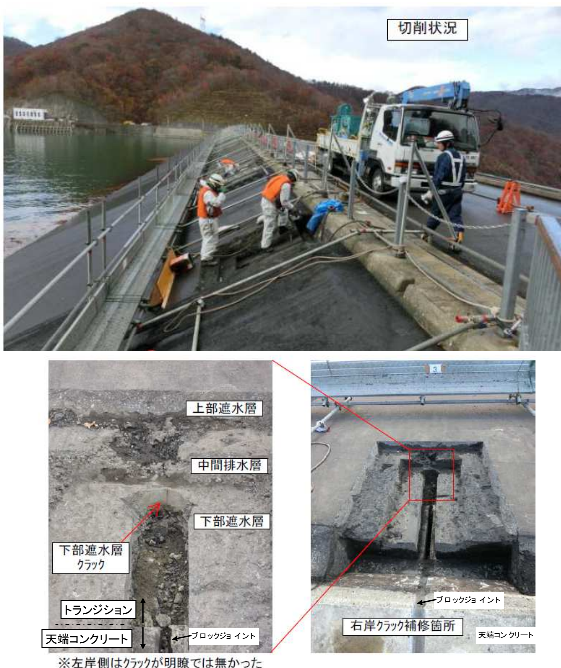
図-6.6.3(1) 天端コンクリート部の補強工状況
