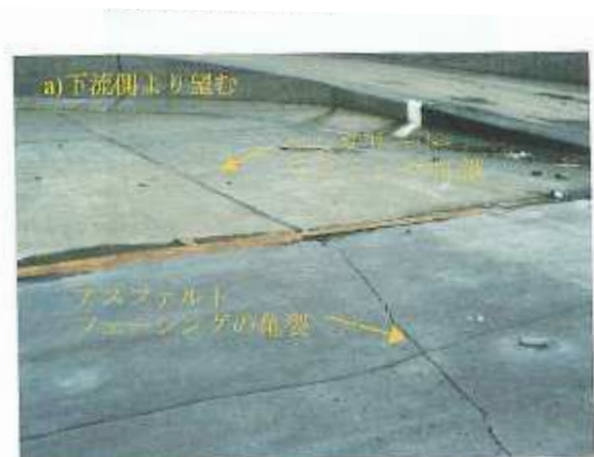
図-2.4.41 コンクリートライニングの打継目により生じた亀裂(1) 42)
