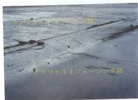
図-2.4.43 不同沈下により生じた亀裂 42)
