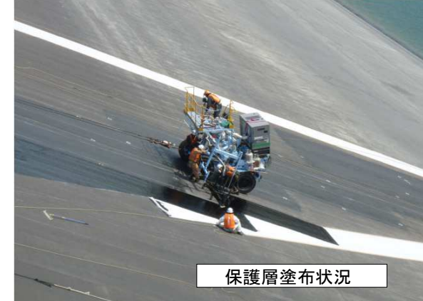
図-6.6.2 補修工施工状況
