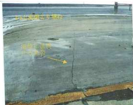
図-2.4.42 コンクリートライニングの打継目により生じた亀裂(2) 42)
