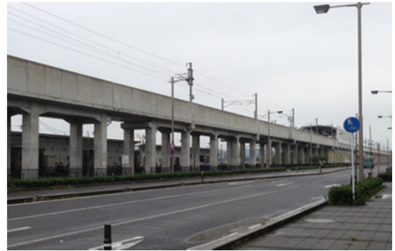
図2.3 普通鉄道の高架橋の例
