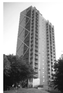
図1 J2棟の外観 (北西より望む)
