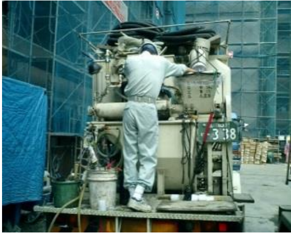
Fig.5-20 ミキサー車を用いた混練の開始
