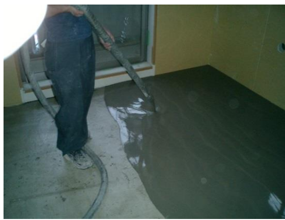
Fig.5-23 セルフレベリング材流し込みの様子
