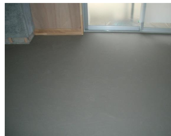
Fig.5-25 セルフレベリング材硬化後の様子
