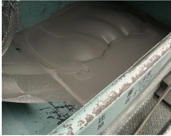
Fig.5-21 セルフレベリング材混練の様子
