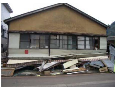
写真1.3 店舗併用住宅の被害<sup>3)</sup>(2004年新潟県中越地震)
