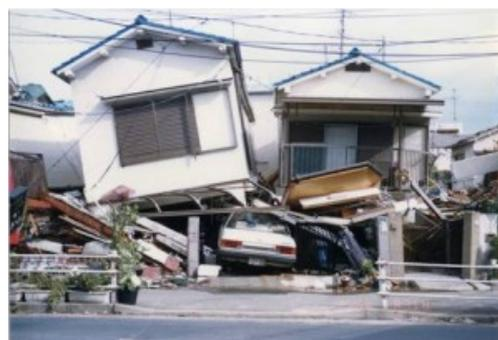
写真1.2 1階にガレージを持つ木造住宅の被害<sup>2)</sup>(1995年兵庫県南部地震)
