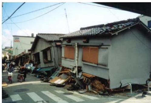
写真1.1 接道面に開口を大きく取った木造住宅の被害<sup>1)</sup>(1995年兵庫県南部地震)
