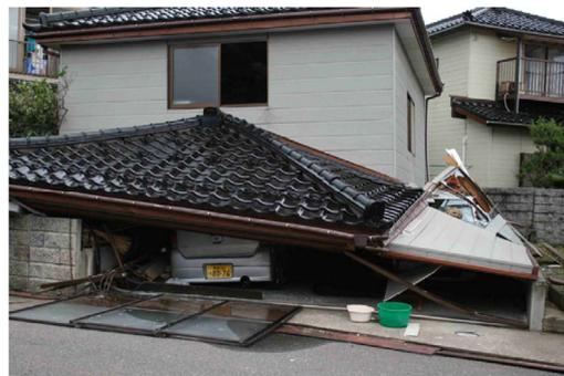
写真 1.8 1階にガレージを持つ木造住宅の被害<sup>6)</sup>(2007年新潟県中越沖地震)
