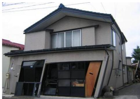
写真 1.7 接道面に大きく開口を取った木造住宅の被害<sup>5)</sup>(2007年能登半島地震)
