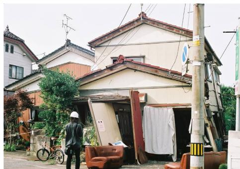
写真 1.6 接道面に大きく開口を取った木造住宅の被害<sup>5)</sup>(2007年能登半島地震)
