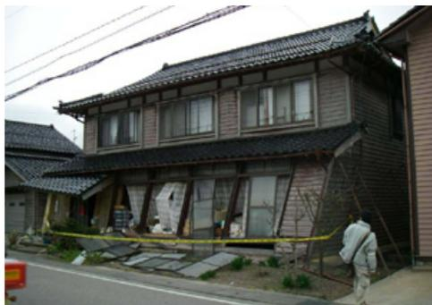
写真 1.5 接道面に大きく開口を取った木造住宅の被害<sup>4)</sup>(2007年能登半島地震)
