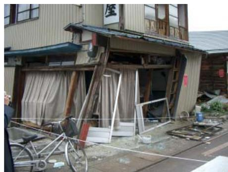
写真1.4 1階が2面開口となった木造住宅の被害<sup>3)</sup>(2004年新潟県中越地震)
