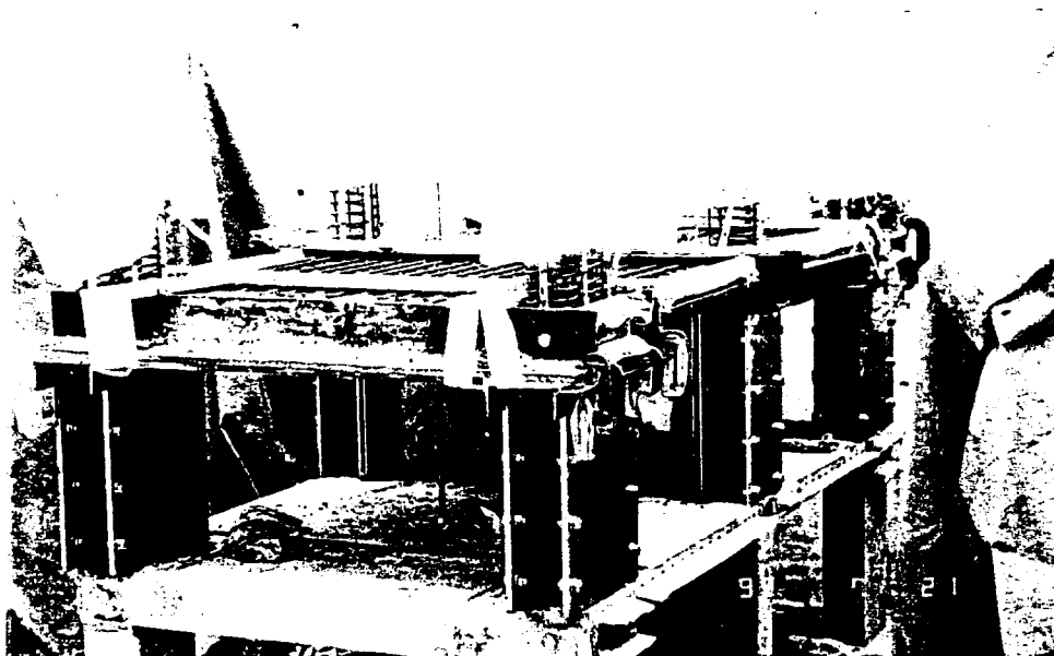
写真 1-9 2層型枠組み
