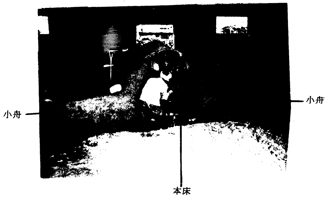
写真 3 - 4 本床と小舟の構築
