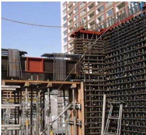
境界梁ダンパー周辺の配筋状況
