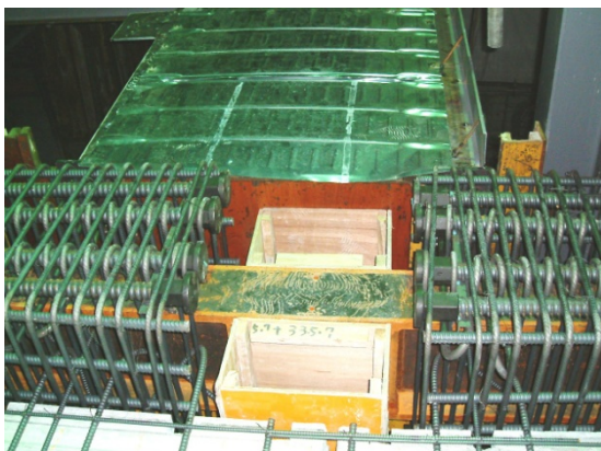
境界梁ダンパー根巻き部配筋
