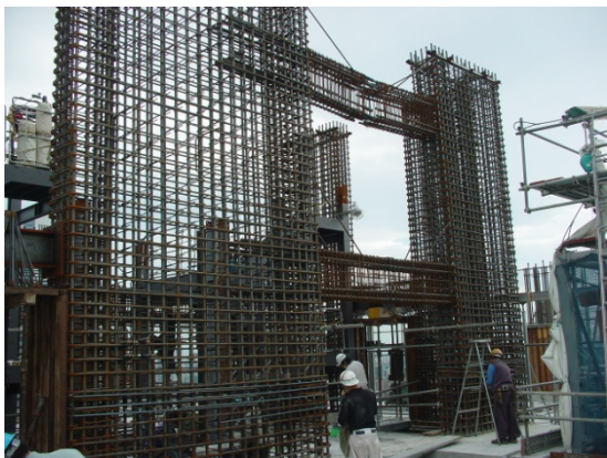
耐震壁の配筋状況
