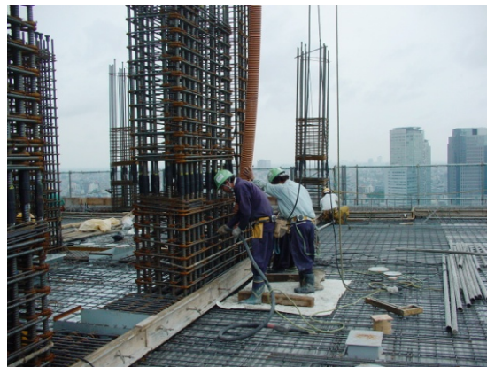
耐震壁のコンクリート打設
