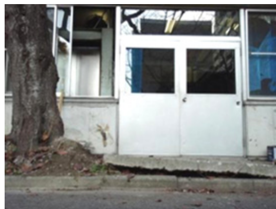
写真2.4 コンクリート板の持ち上げ
