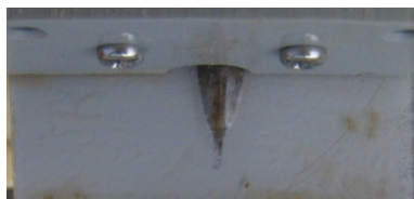
写真5.9 シート防水ジョイント部の剥離状況(溶着剤による接着)
