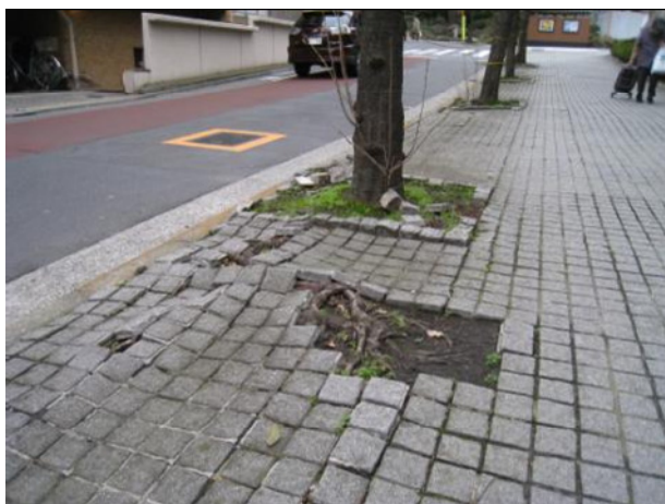
写真1.1 根による歩道舗装の損傷事例
