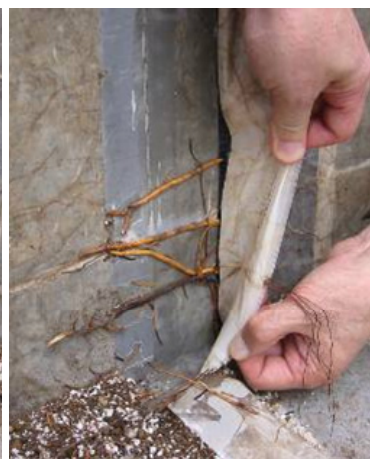
写真1.3 耐根シートジョイント部への根の侵入事例
