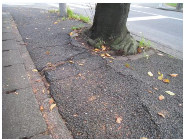
写真1.1 根による歩道舗装の損傷事例
