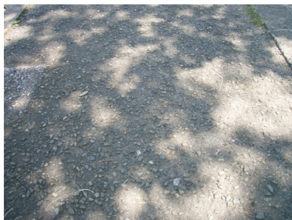
写真3.10 アスファルト舗装の路面の状態
