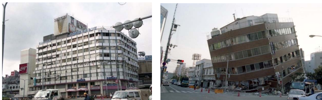
図 1-2 ねじれ崩壊・層崩壊の事例 (写真提供：神戸市)
