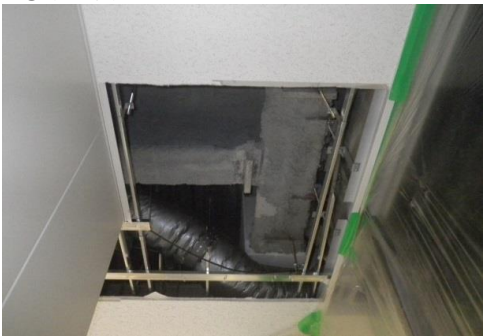
③天井一部撤去
