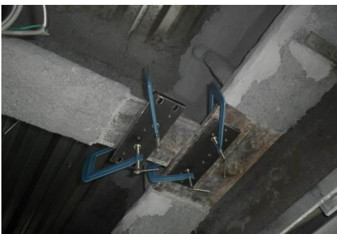
⑤アクチュエータ取付け治具の設置
