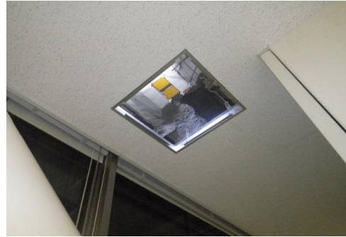
⑨天井復旧，点検口取付け
