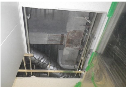
④耐火被覆一部撤去
