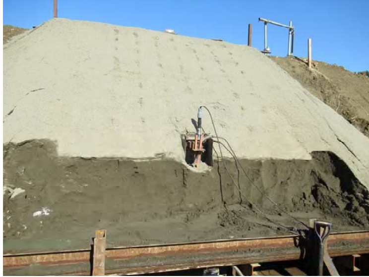
付 C 写真 1.3 掘削途中段階
