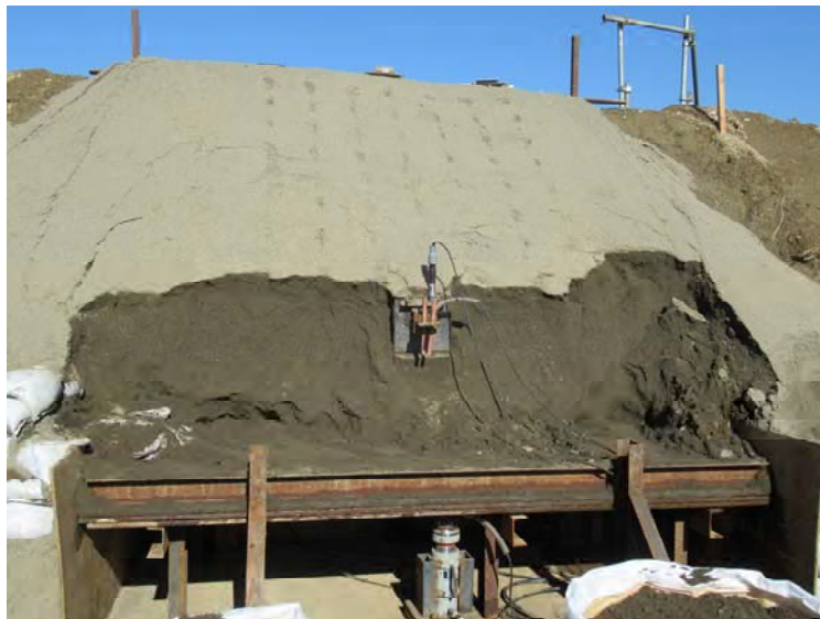
付 C 写真 1.4 掘削途中段階
