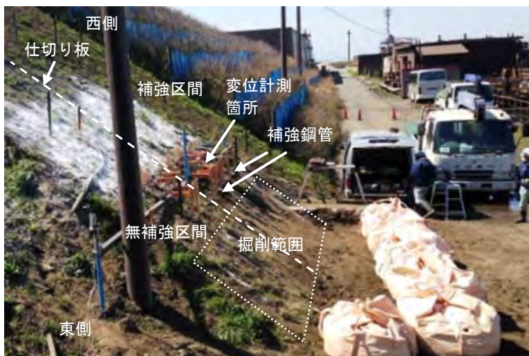
写真 5.4.2 法尻掘削実験前の状況
