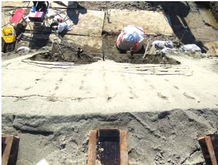
付 C 写真 1.8 受圧板が支持する移動土塊の範囲を確認（法肩から下方）
