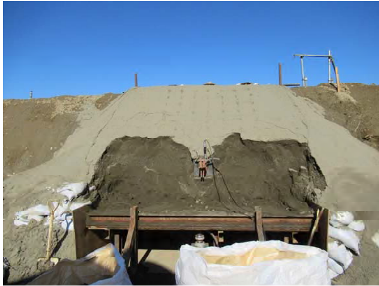
付 C 写真 1.5 掘削途中段階
