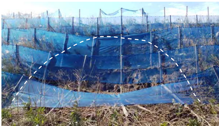
写真 5.6.1 隣接の無補強斜面が崩壊した痕跡（白線から下側が崩壊）
