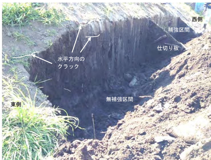
写真 5.4.3 無補強区間の垂直掘削面【30分】
