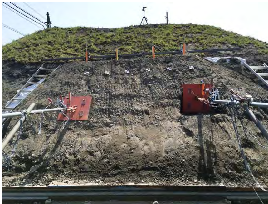
写真 5.3.1 試験盛土全景
