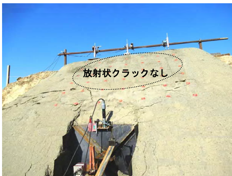
写真 3.3.5 TK-800 除荷実験後
