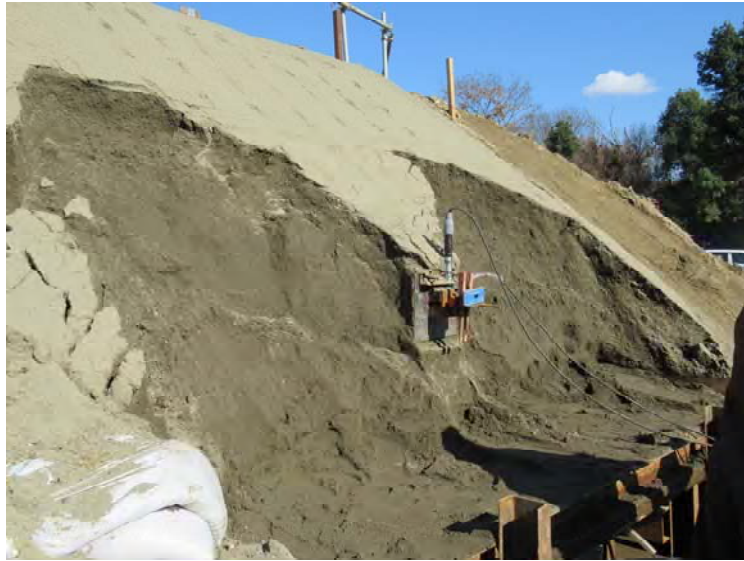
付 C 写真 1.7 受圧板が支持する移動土塊の範囲を確認（側面）
