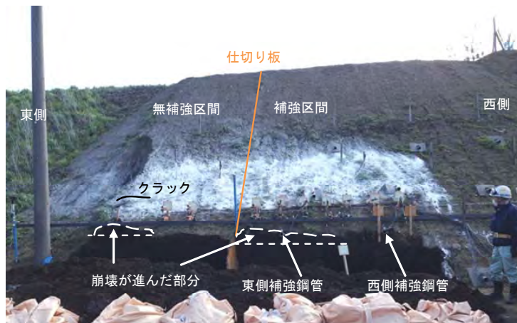
写真 5.4.8 斜面正面から見たオーバーハング掘削面【70分】
