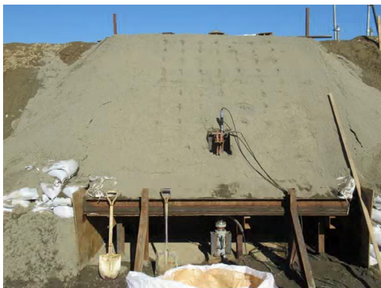
付 C 写真 1.1 掘削前
