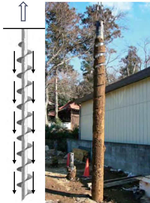
写真 4.2.1 地中から引き抜いた羽根付き鋼管杭 4-7)
