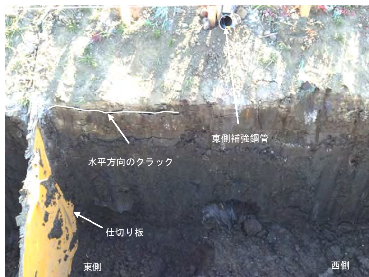
写真 5.4.4 補強区間の垂直掘削面【31分】
