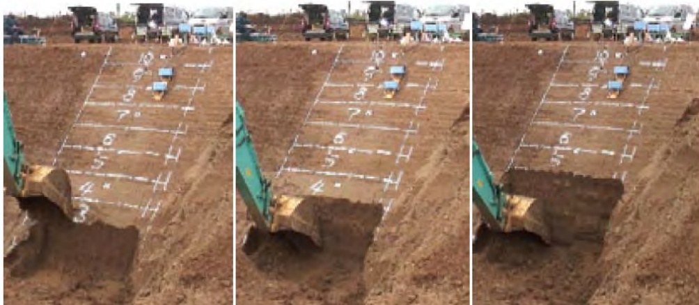
写真 5.2.1 掘削による斜面の実験状況 5-5)
