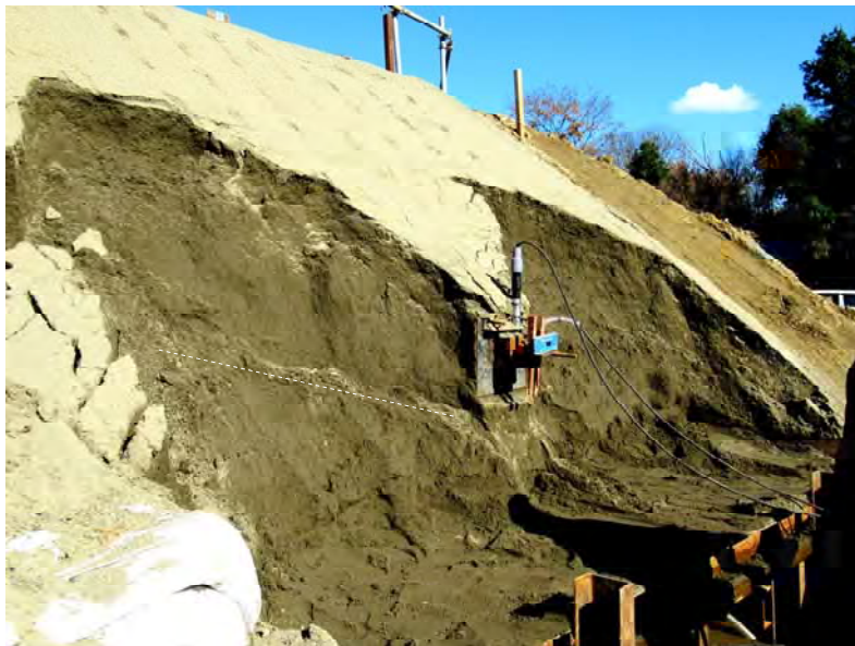
写真 3.3.6 受圧板が支持する移動層側面 (TK-300)
