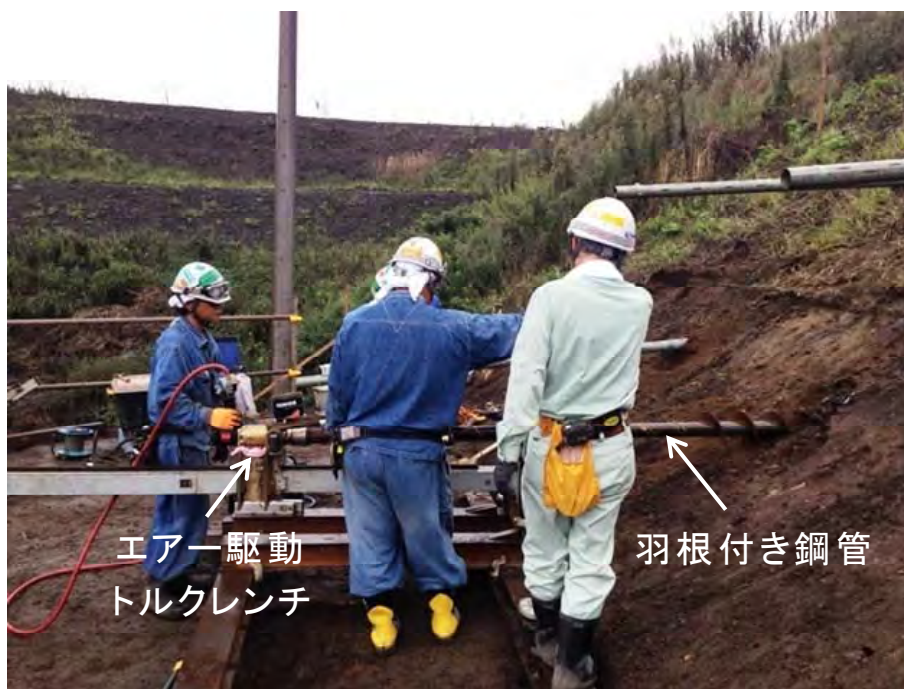
写真 1.1.5 羽根付き鋼管の施工例
