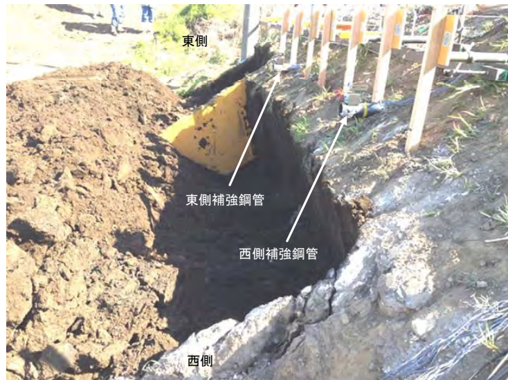
写真 5.4.6 補強区間のオーバーハング掘削面は自立【48分】
