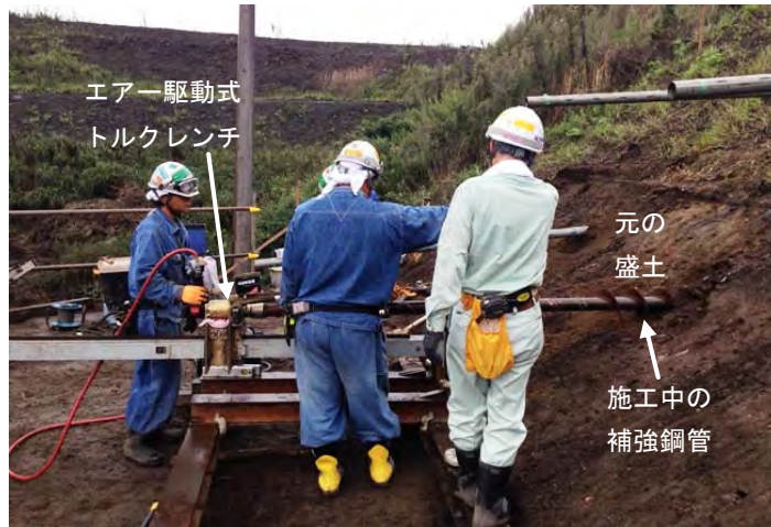
写真 5.6.4 鋼管の施工状況
