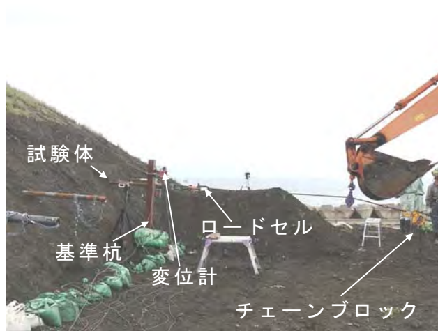
写真 4.4.2 引抜き実験状況（現場 KMW）
