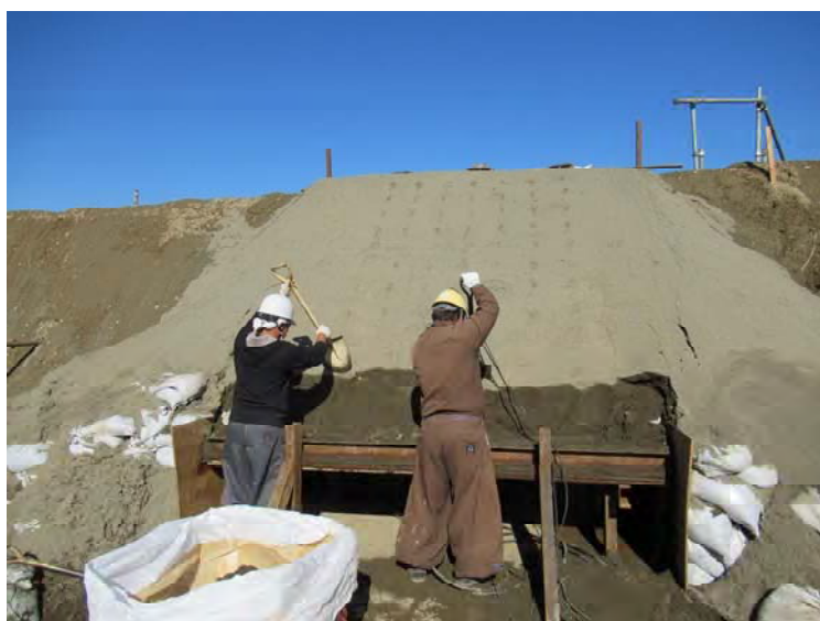
付 C 写真 1.2 掘削状況
