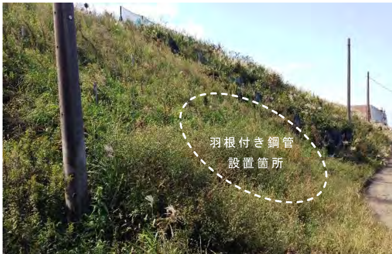
写真 5.6.6 完成から 1 年経過した試験盛土 (2015 年 10 月)
