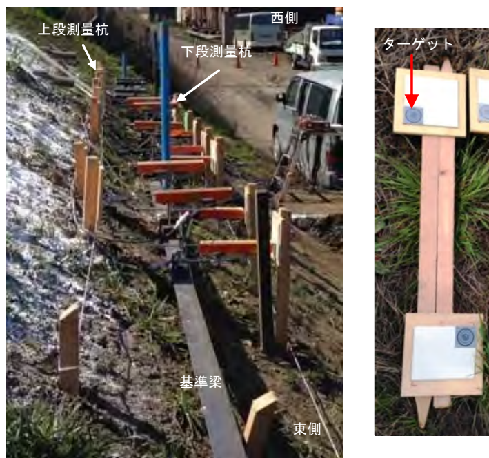
写真 5.4.1 変位計の設置状況(写真左)と測量杭(写真右)
