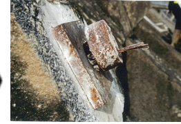
【コンクリートキャップ撤去】
