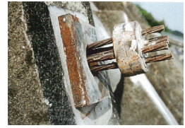
【コンクリートキャップ撤去】
